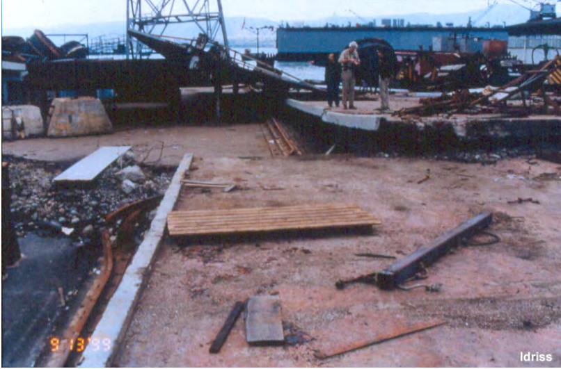
Şekil 2. 1999 Gölcük depreminden sonra burada görülen beton plakalardaki ofset ile kanıtlandığı gibi, Türk Deniz Kuvvetlerine bağlı Donanma tesislerinde sağ yanal fay hareketleri gelişmiş ve sonucunda liman önemli ölçüde hasar görerek kullanılamaz hale gelmiştir. (Fotoğraf; UC Davis, Civil and Environmental Engineering https://research.engineering.ucdavis.edu/gpa/earthquake-hazards/liquefaction-ports/ internet adresinden elde edilmiştir)
