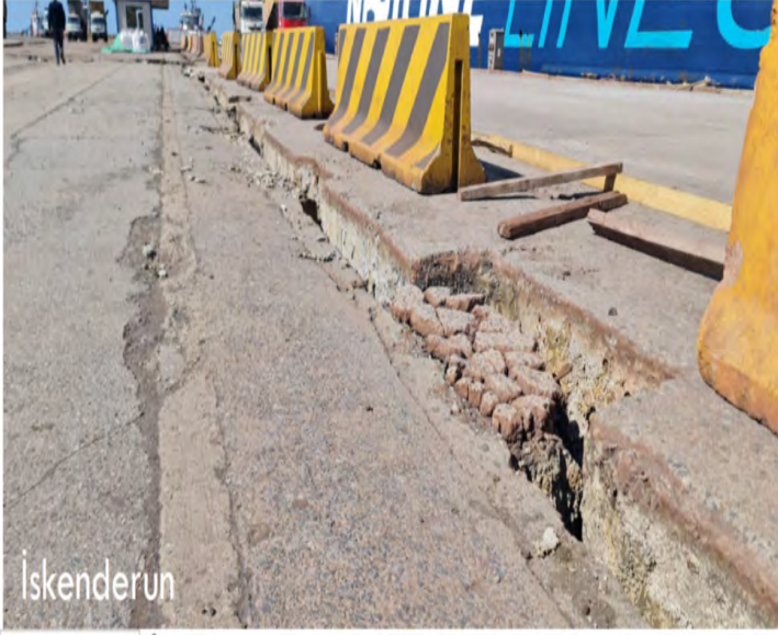
Şekil 3. Eski İskenderun limanında anolar arası kalıcı deplasmanlar ve çarpışma sonucu oluşan kayma kaması hasarları. (Yapı Deprem Mühendisleri Platformu 2023)
