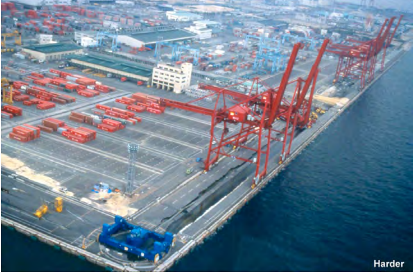
Şekil 1. Hyogoken-Nanbu (1995) depreminin ardından Rokko Adası'nın bir köşesinin havadan görünümü. Yüzeydeki (sol alt köşe) açık renkli malzeme, sıvılaşma sonucu yüzeye kaynayan kumdur. Ada büyük keson “rıhtım” duvarlarıyla çevrilidir ve çevreleyen su yaklaşık 15 m derinliğindedir. (Fotoğraf; UC Davis, Civil and Environmental Engineering https://research.engineering.ucdavis.edu/gpa/earthquake-hazards/liquefaction-ports/ internet adresinden elde edilmiştir)
